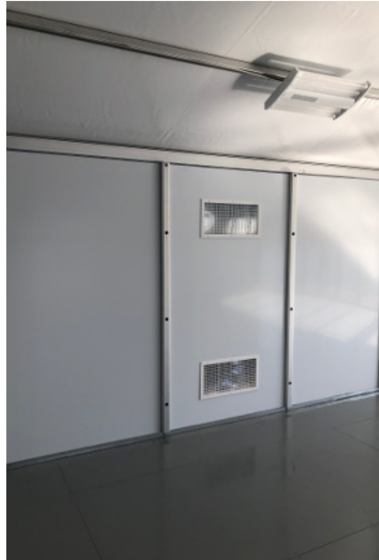
Vue intérieure Mur rigide en « Alupanel»
