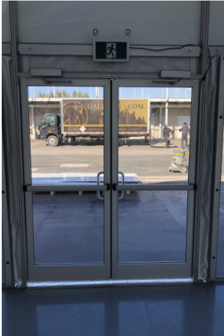
Vue intérieure porte vitrée
